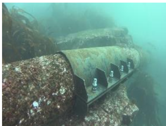
Abrazadera N°5 instalada a 16 metros de profundidad y 1.140 metros de longitud
