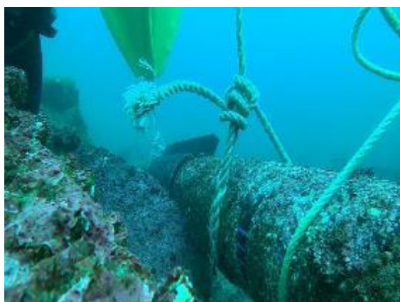
Maniobra de instalación de abrazaderas N°1 y N°2 con globos de levante
