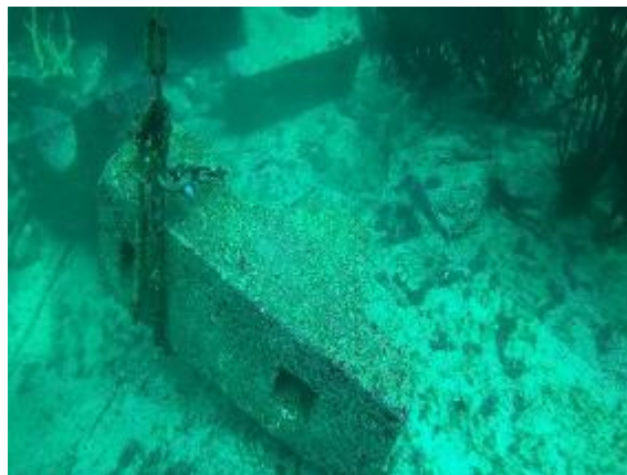
Reconexión de lastres a abrazaderas de refuerzo entre los 915 metros y los 1.170 metros
