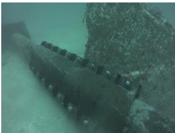
Abrazadera N°1 instalada a 43 metros de profundidad y 500 metros de longitud
