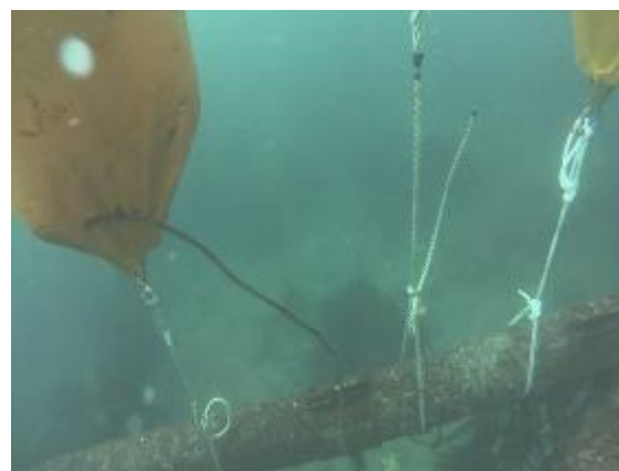
Maniobra de instalación de abrazaderas N°2 y N°5 con globos de levante
