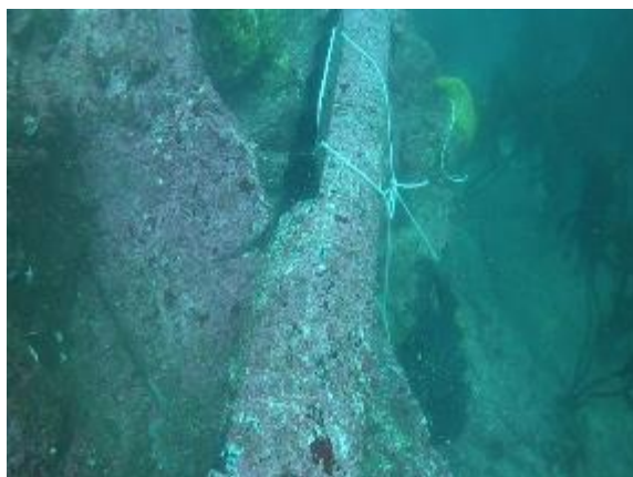
Sector previo a instalación de Abrazadera N°2 a 21 metros de profundidad
