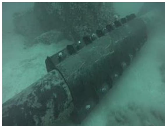
Abrazadera N°1 instalada a 43 metros de profundidad y 500 metros de longitud
