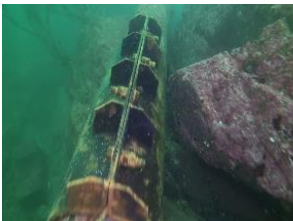
Abrazadera N°2 instalada a 21 metros de profundidad 970 metros de longitud
