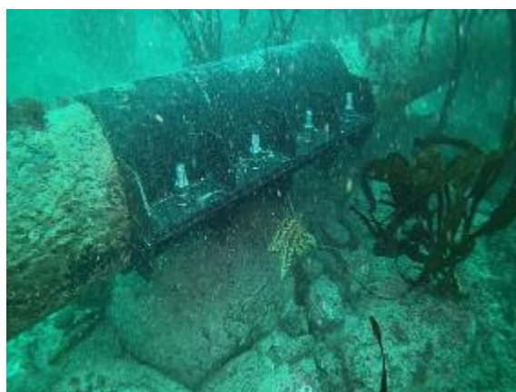
Abrazadera N°4 instalada a 16 metros de profundidad y 1.110 metros de longitud
