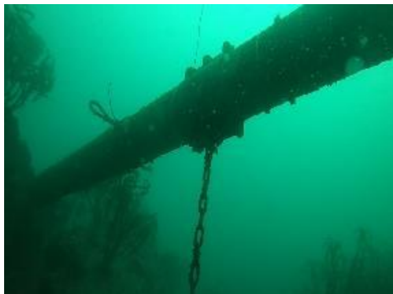
Reconexión de lastres a abrazaderas de refuerzo entre los 915 metros y los 1.170 metros
