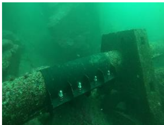
Abrazadera N°3 instalada a 18 metros de profundidad y 998 metros de longitud
