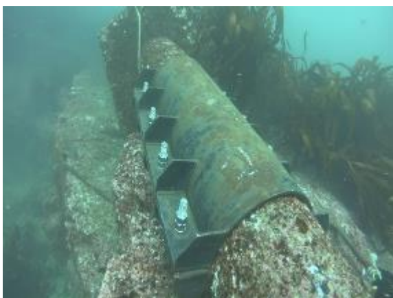
Abrazadera N°5 instalada a 16 metros de profundidad y 1.140 metros de longitud
