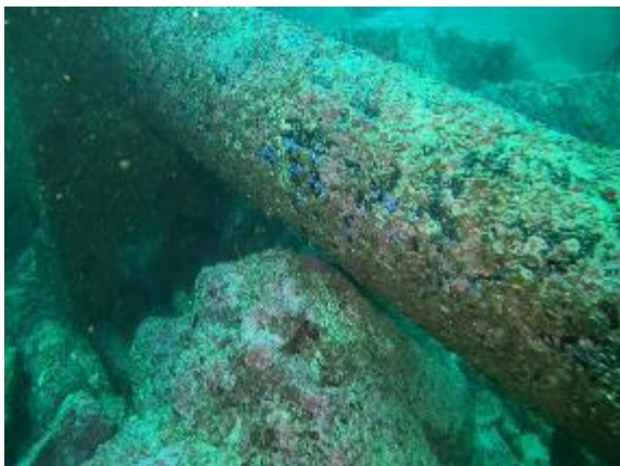
Sector previo a instalación de Abrazadera N°3 a 18 metros de profundidad
