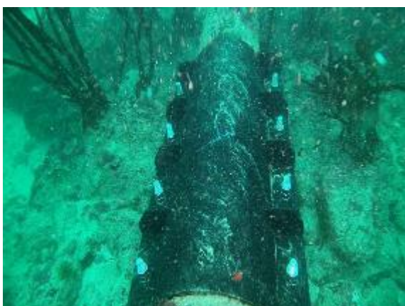
Abrazadera N°4 instalada a 16 metros de profundidad y 1.110 metros de longitud
