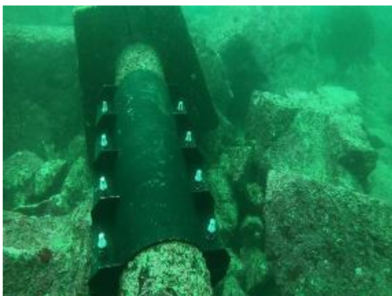
Abrazadera N°3 instalada a 18 metros de profundidad y 998 metros de longitud
