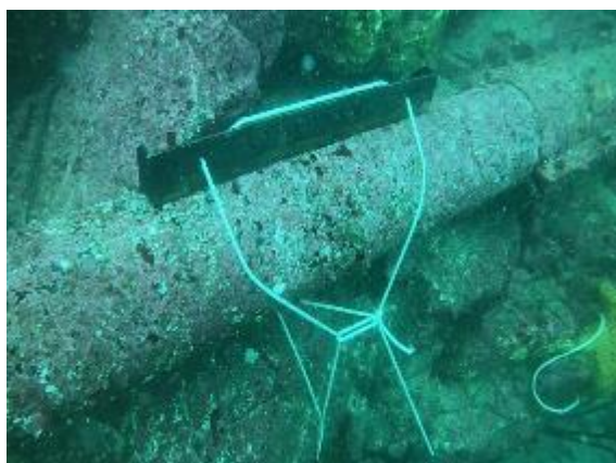
Maniobra de instalación de abrazaderas N°2 y N°5 con globos de levante
